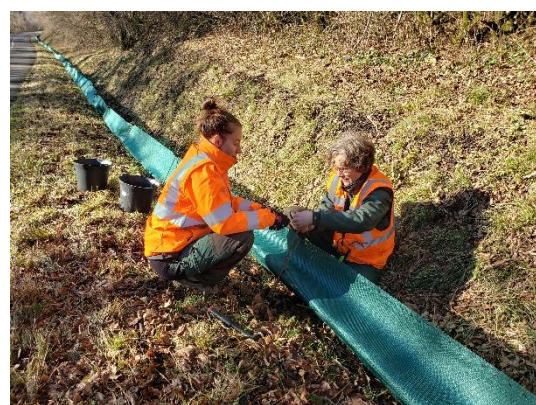
Figure 5 : Installation du dispositif amphibiens (01/02/2025)
